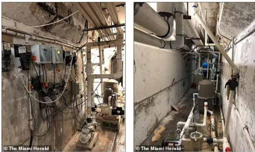
Fotografías del cuarto técnico, tomadas cuatro días antes del colapso, que documentan el deterioro generalizado del concreto y la corrosión del acero de refuerzo.
