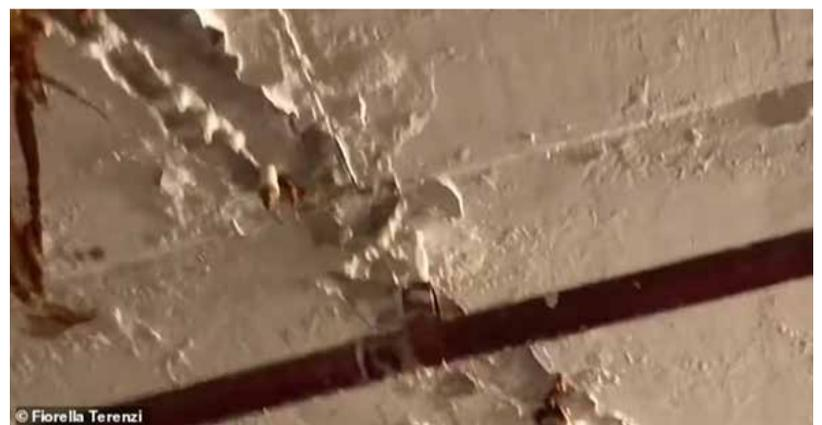
Fotografía tomada en el año 2020 por una compradora potencial que documenta el agrietamiento y descascamiento del concreto en el garaje subterráneo.
